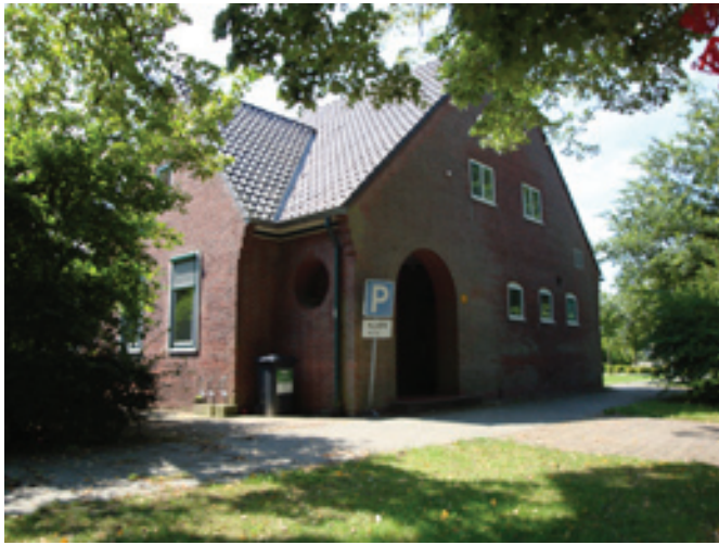
Z21 Kantoorgebouw Huidige toestand: het pand heeft een bijzondere entree met een rondboog. De vensters zijn vervangen door een moderne variant, de schokbetonnen lijsten zijn behouden.
