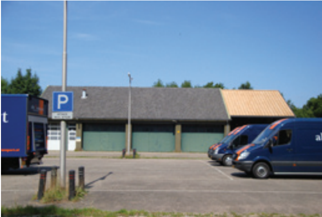
Z85 Stalling Huidige toestand: aan de zijgevel is een nieuw deel aangebouwd.
