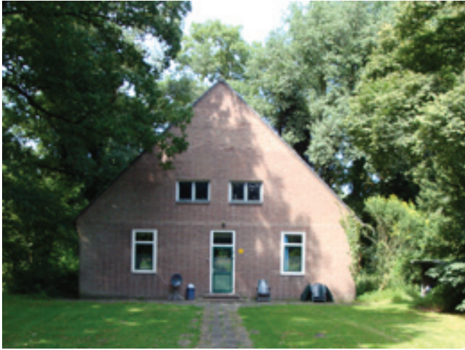
Z13 Kantoorgebouw Huidige toestand: het pand heeft moderne vensters en deuren gekregen.
