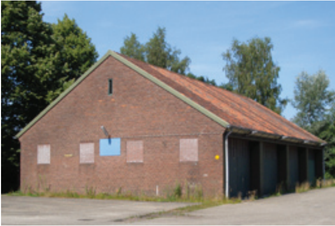
Z86 Werkplaats/stalling Huidige toestand: de vensters van de zijgevel zijn dichtgemetseld.
