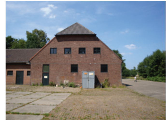
Drie soorten bestrating, betonplaten, klinkers en asfalt rondom gebouw Z80
