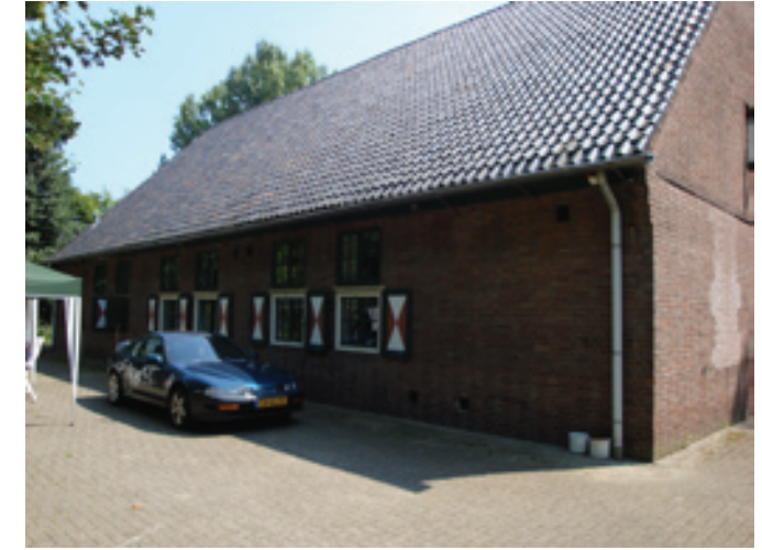
Z49 Kantoorgebouw Huidige toestand: details als de luiken, roedeverdeling en de tralies voor de ramen zijn bewaard gebleven. Een van de vensters aan de voorgevel is dichtgemetseld.
