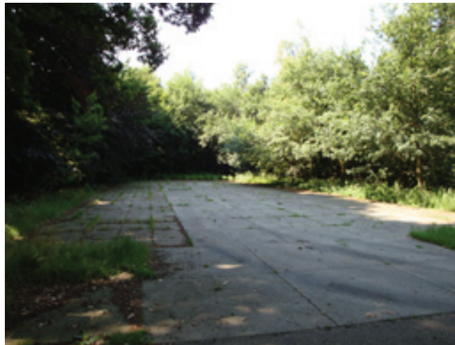
Bestrating van betonplaten
