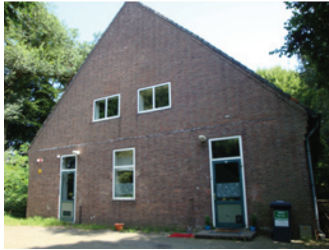
Z66 Legeringsgebouw Huidige toestand: het pand is gemoderniseerd met kunststof kozijnen en deuren.
