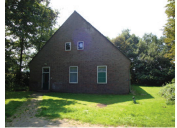
Z62 Legeringsgebouw Huidige toestand: moderne vensters en deuren.
