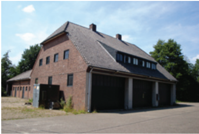
Z80 Werkplaats Huidige toestand: typisch Duits dak.
