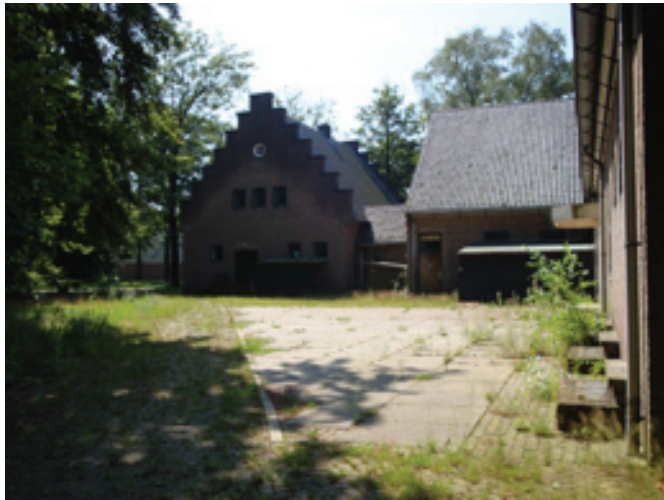
Z31 Kantoor, lesgebouw en magazijn Huidige toestand: bijzondere details zijn de trappengevel en de vensters met roedeverdeling.
