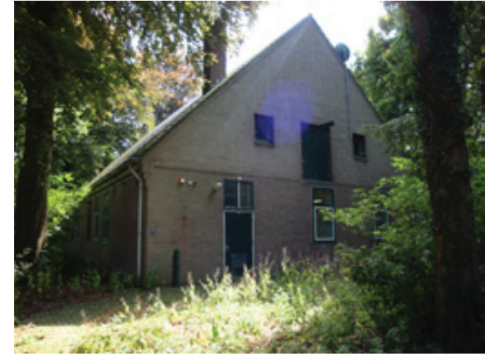
Z15 Legeringsgebouw Huidige toestand: een deel van de vensters is vervangen. De katrol is bewaard gebleven.
