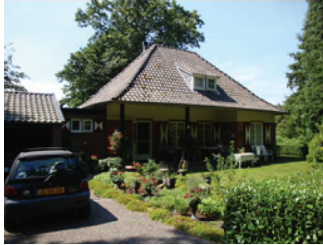
Z43A Woning Huidige toestand: de stalen luiken zijn vervangen door een houten versie. De vormgeving wijkt af van de andere woningen door het schilddak, de witte band onder het dak en de houten betimmering aan de achtergevel.
