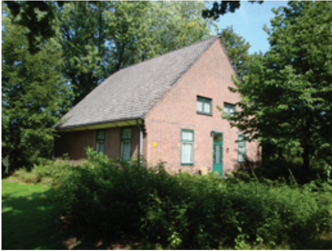
Z40 Hobbyclubs Huidige toestand: de vensters en deuren zijn vervangen door een moderne variant.
