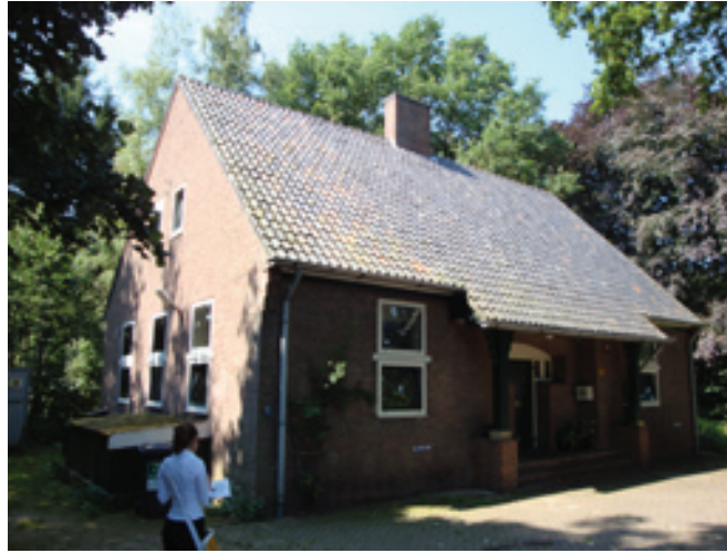
Z53 Geneeskundige inrichting Huidige toestand: De kozijnen zijn vervangen. De entree heeft een overkapping ondersteund door houten kolommen.
