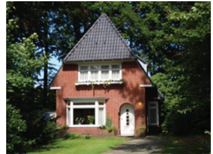
Z22A Legeringsgebouw Huidige toestand: bijzonder omdat het voor de oorlog is gebouwd en een dak heeft met wolfseinden.
