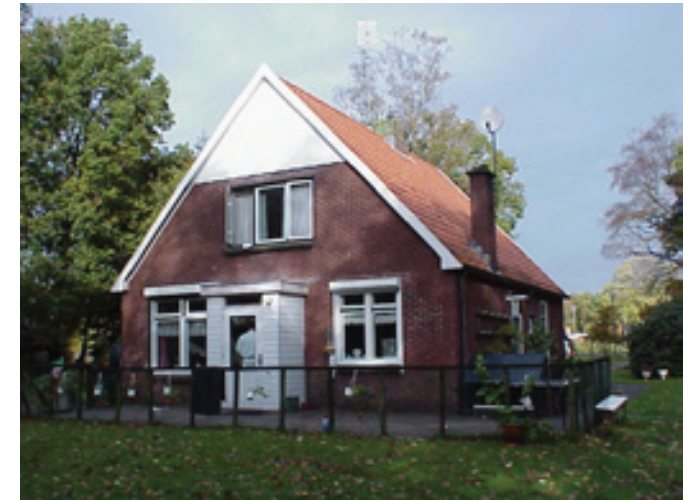
Z90 Woning Huidige toestand: de vensters zijn vervangen, de entree heeft een uitbouw gekregen en de houten betimmering in de nok en de dakomlijsting zijn waarschijnlijk later toegevoegd.
