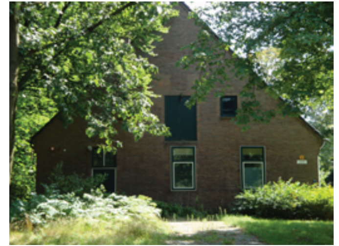
Z27 Legeringsgebouw Huidige toestand: de vensters en deuren zijn vervangen. De schokbetonnen lijsten om de kozijnen zijn nog duidelijk zichtbaar, eveneens als het katrol.
