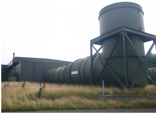
Vliegveld / centrum: installatie voor beproeving motoren.
