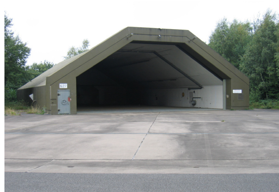
Vliegveld: bunkers voor straaljagers zijn in reeksen en clusters gebouwd.
