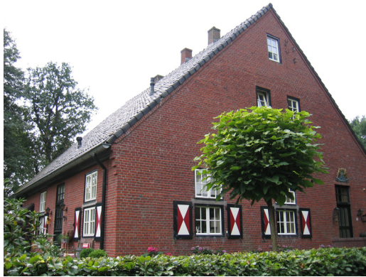
Camouflage architectuur, regionale bouwstijl en materiaal is toegepast om de bunkers die gebruikt werden als legeringsgebouwen te camoufleren.
