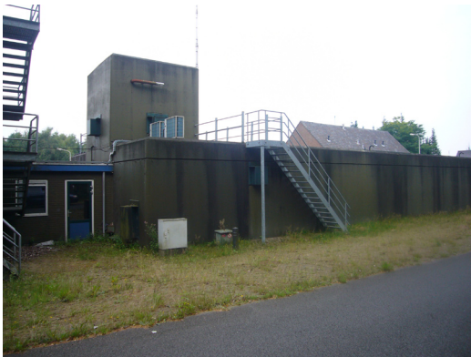
Bunkers van de commandopost Centrum.
