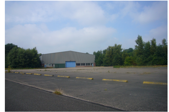
Hangar ringweg westzijde.
