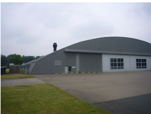
Vm. Oostkamp: moderne hangar met lichte gebogen vakwerkspanten.
