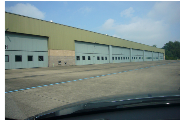
Grote hangar in cluster westzijde.
