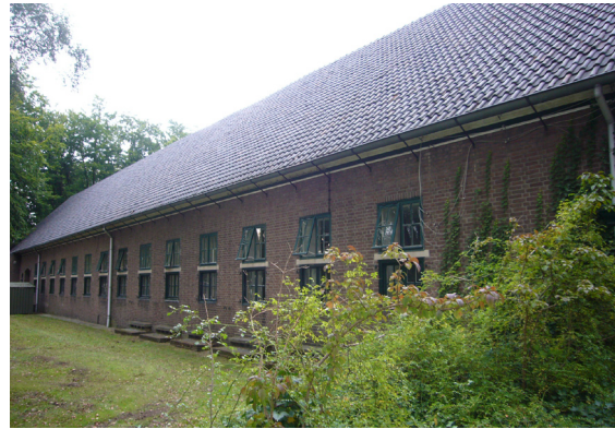
Camouflage architectuur, regionale bouwwijze en materiaal is toegepast om de bunkers die gebruikt werd voor bijeenkomsten te camoufleren.
