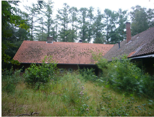
Vm. Oostkamp: gebouw voor verbindingen, ook in camouflage-architectuur (luiken, baanderdeuren, pannendak, etc.)
