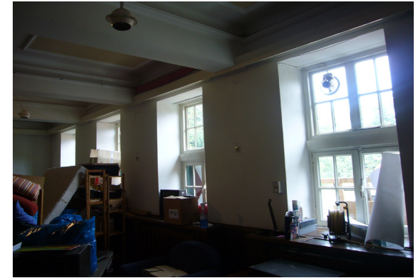
PBK 14: interieur met dikke betonmuren en plafonds.
