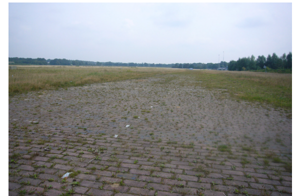
Duitse rolbaan gemaakt van traditionele klinkers ( met reflecterende geëmailleerde stenen).
