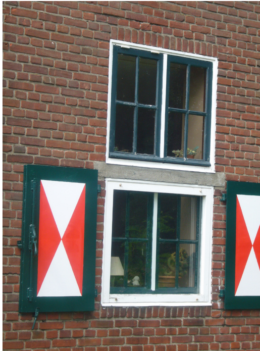
Camouflage architectuur, vensters in Oud Hollandse stijl, de luiken zijn van staal ter bescherming tegen oorlogsgeweld.
