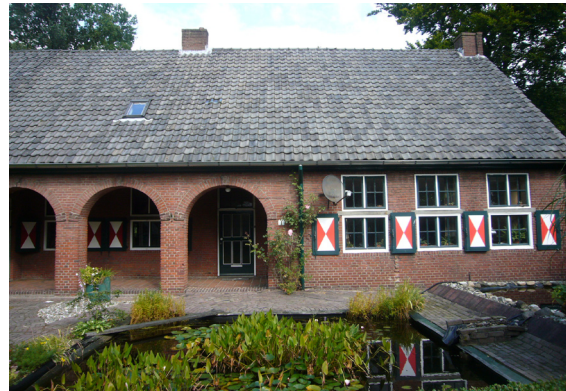
PBK 1: Wachtgebouw bij ingang, zijgevel
