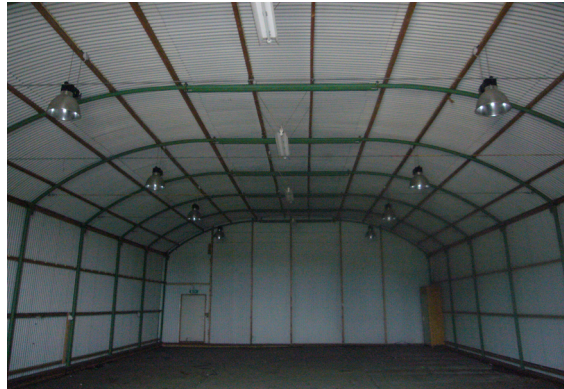
Vm. Oostkamp: Romney-loods als kleine hangar: interieur.
