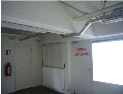
Zware betonnen liggers en plafonds scheiden de begane grond van de zolder.
