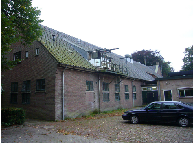
ZK 17: Zaal achter kapel met aanpassingen en nieuwe aanbouw
