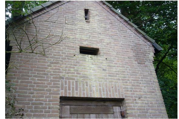
Trafohuisje Prins Bernardkamp voorzien van schietgaten.
