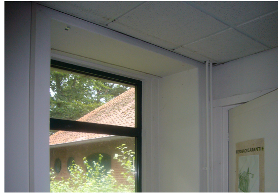
Vm. Oostkamp, verbindingen: de romantische architectuur verhult wanden van 50 cm beton en een betondek van decimeters dik.
