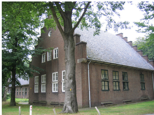
Camouflage architectuur, Oud Hollandse bouwstijl is op verschillende manieren toegepast om de bunker te verhullen.
