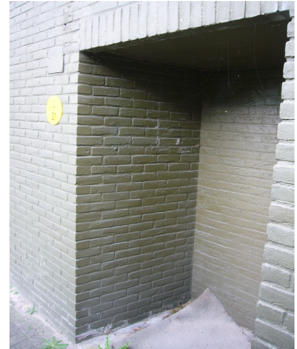
Camouflage architectuur, bij een dichtgezette ingang van een schuikelder is de decimeters dikke betonmuur van de bunkers goed te zien.
