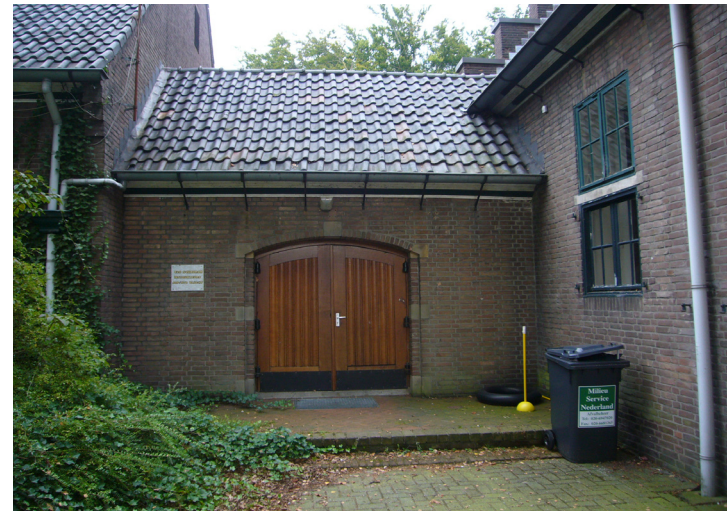
ZK 31: Entree tussen dwarshuis en langshuis.
