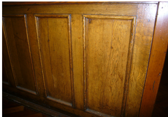
ZK 31: Lesgebouw, aula met eiken parketvloer en lambrisering.
