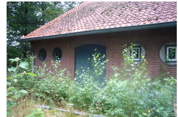
Camouflage architectuur, gevel met stalramen en deeldeuren de stalramen zitten te hoog en de deeldeuren zijn slechts façade, daarachter zit een betonnen muur.
