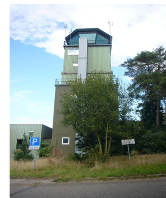
De verkeerstoren werd met een staalconstructie verhoogd.
